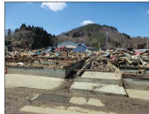
●基礎のいずれかの辺が全部破壊し、基礎直下の地盤が流出・陥没
